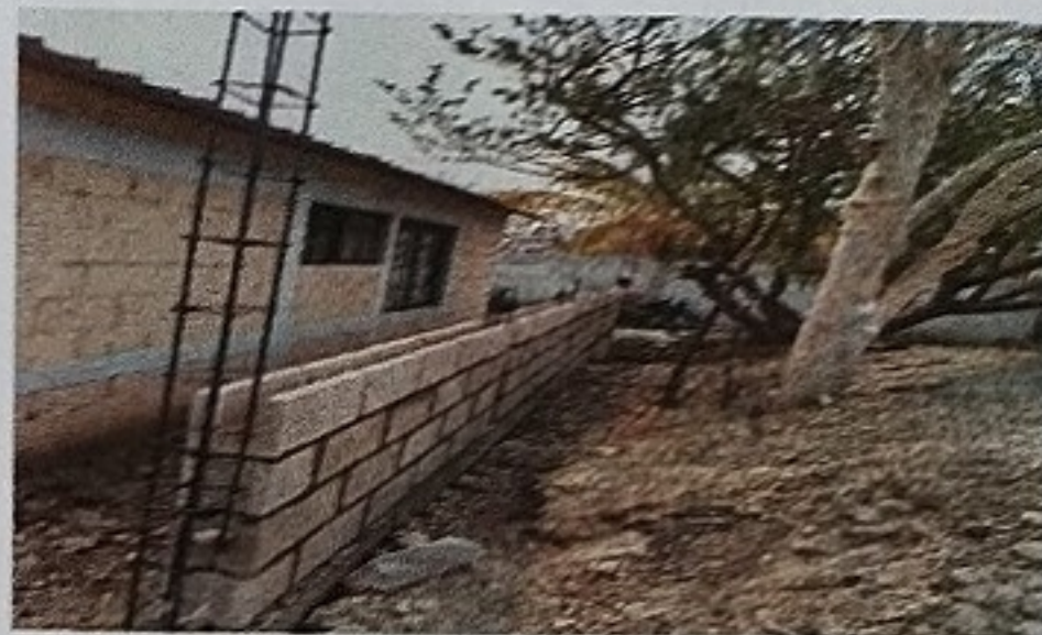
Foto 4: área en proceso de mejoramiento de muro perimetral
