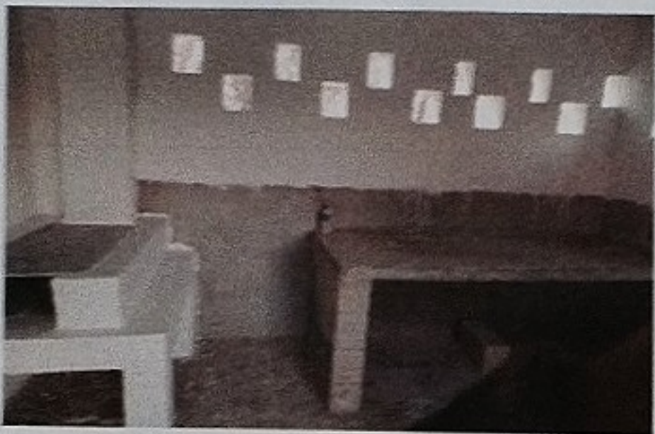
Foto 3: área intervenida cocina, mejoramiento en proceso
