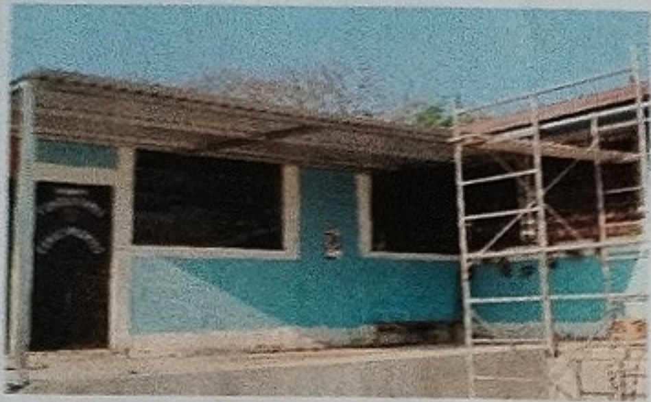
Foto 1: Colocación de cubierta de techo con estructura en el proceso
