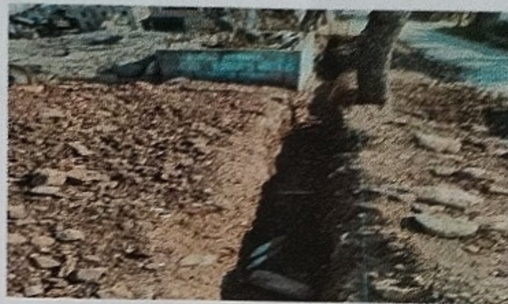
Foto 2: Inicio de trabajo mejoramiento de muro al frente y costado del centro Educativo
